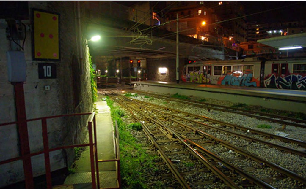
Illuminazione LED Stazione Porta Nolana
